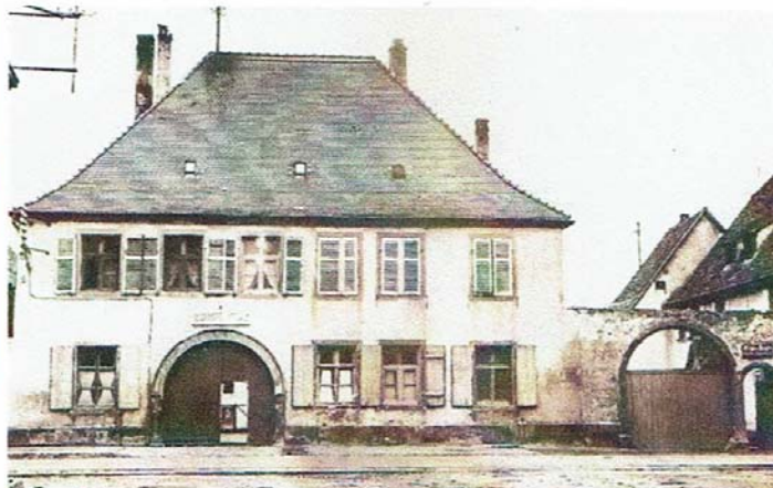
Dans ce bâtiment, construit autour des années 1700 et sans doute ancienne auberge, fut logée de 1857 à 1978 la brigade de gendarmerie de Marckolsheim. Depuis 2016, les militaires occupent des locaux fiambant neufs à l'entrée nord de la ville. DOC. REMIS - COLL. R. BAUMGARTEN
